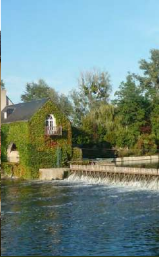
Site de Nitray à Athée-sur- Cher - barrage à aiguilles et moulin
