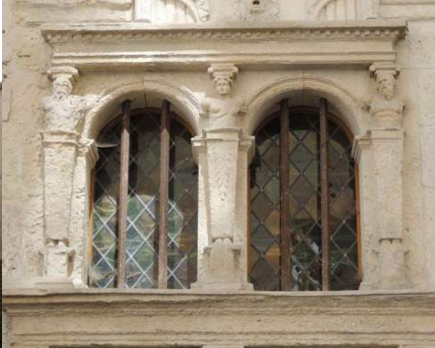
Sur la façade de la maison de la Coquille, trois termes délimitent les deux jours d'imposte de la porte d'entrée et supportent un entablement
