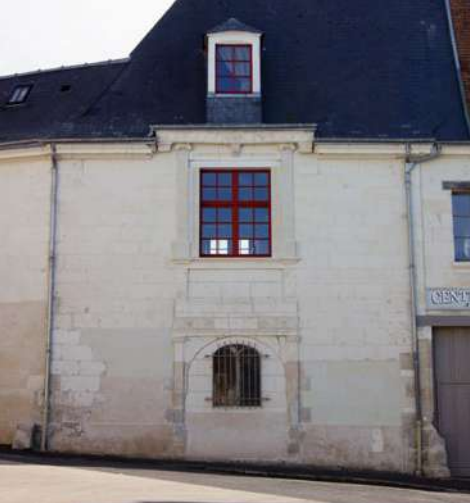
Centre paroissial : l'une des rares maisons Renaissance située hors les murs de la ville
