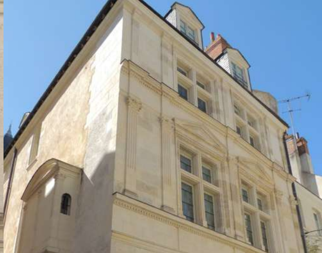
Le cabinet en encorbellement de l'hôtel Hector-de-Sanxerre est percé d'étroits jours sur ses parois latérales et est porté par de riches consoles en volutes ornées de masques ou de feuillages
